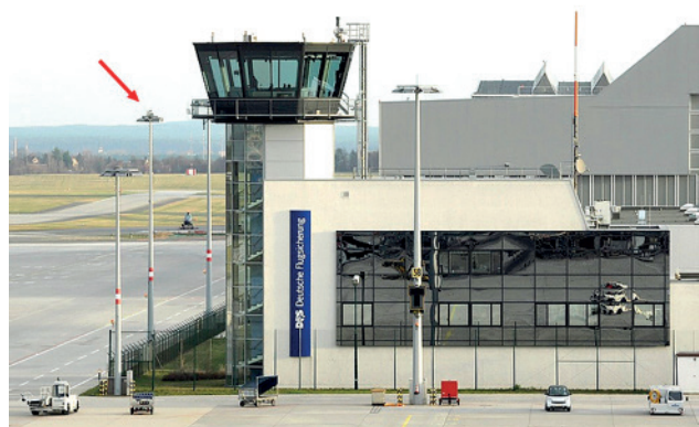
Tower auf dem Dresdener Flughafen mit Laternenmasten, die das Vorfeld beleuchten
