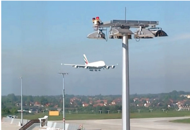
Das technische Equipment auf dem Laternenmast
